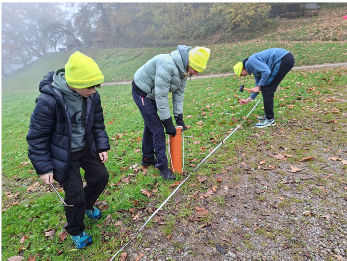
Installation von 75 Edelstahlelektroden im Abstand von jeweils 1 m (Tom, Helen, Siméon)
