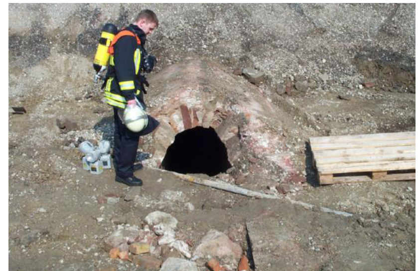
Anschnitt des Tunnels beim Bau der B28 in 2002 (Gras)
