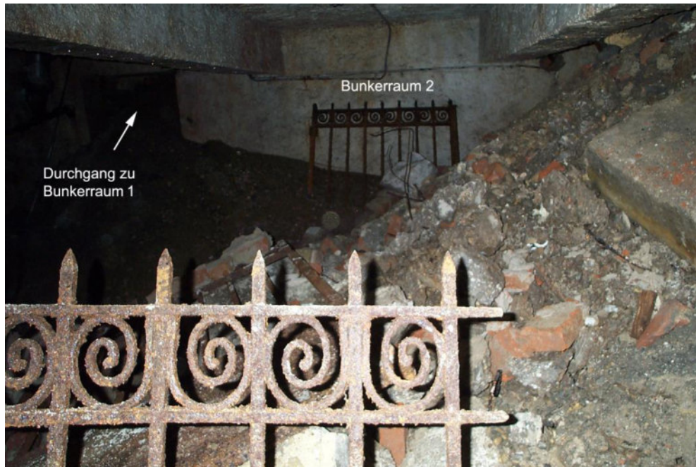
Bunkerräume und Tunnel heute (Moll)
