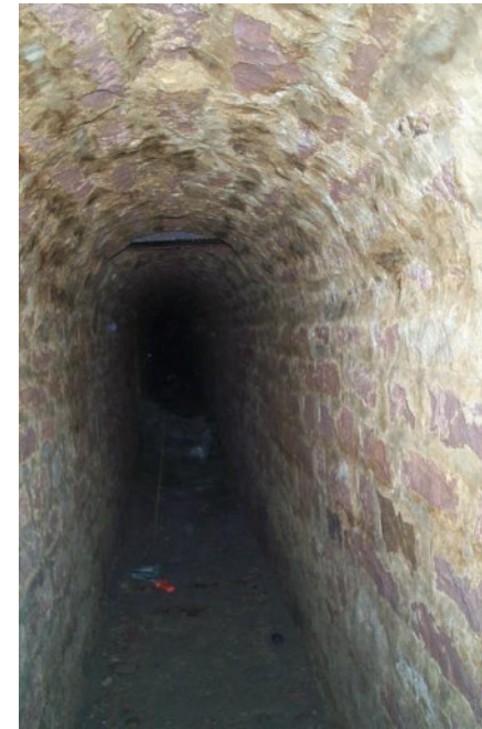
Tunnel heute – begehbarer Abschnitt (Moll)
