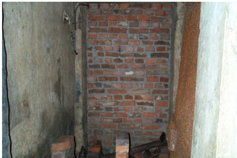
Nordende des Tunnels im Keller der Pionierkaserne – zugemauert seit 1970igern (Gras)
